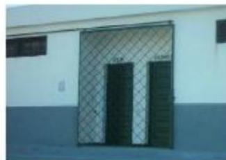
Portón de las instalaciones sanitarias
