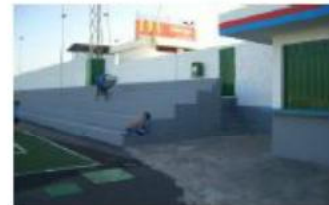
Final de las gradas y escaleras
