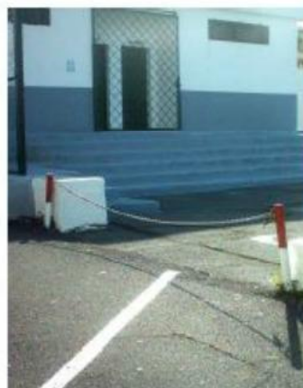
Estacionamiento y acceso
