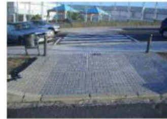
Acera y paso de peatones
